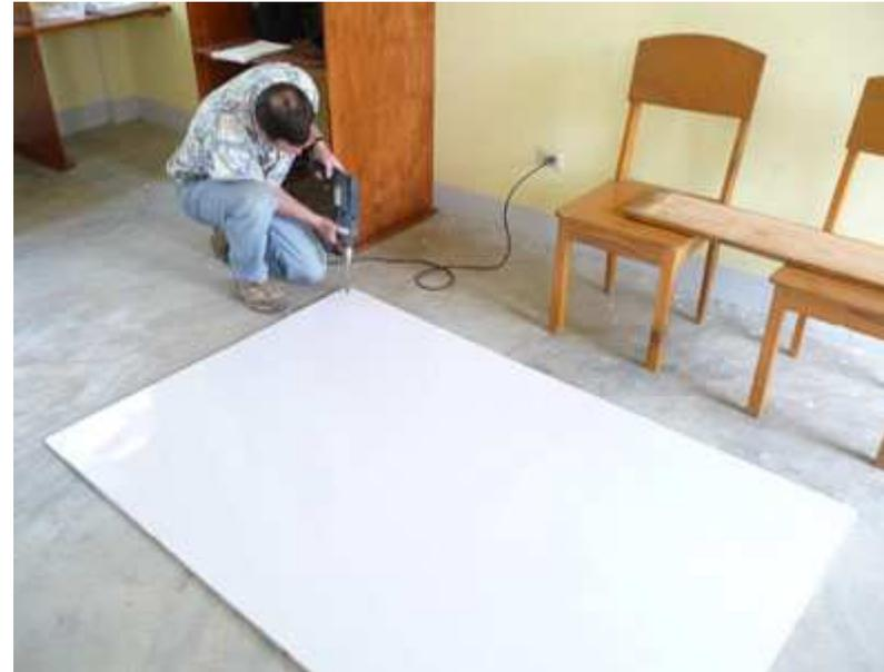
*Perçage des trous de fixation*
